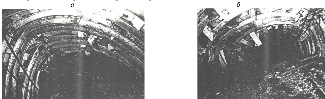
Рис. 1. Проявление неравномерности смещений пород по контуру вироботок: а - в 8-м западном полевом штреке гор. 840 м шахты «Новодружеская», б - в 7-м западном полевом вентиляционном штреке пласта m_3^H гор. 650 м шахты им. Г.Г. Капустина
