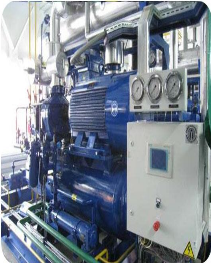
Рисунок 4.13. Загальний вигляд диспетчерської автоматики холодильної системи
