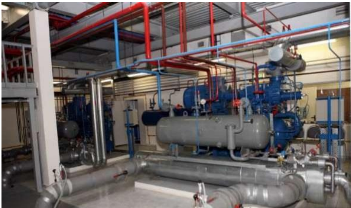
Рисунок 4.2. 3Д компанування обладнання холодильної машини
